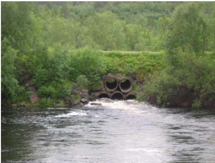
Elva er lagt i kulvert. Høy vannføring gjør at det skapes et vandringshinder for fisk. Foto: Knut Aune Hoseth.
